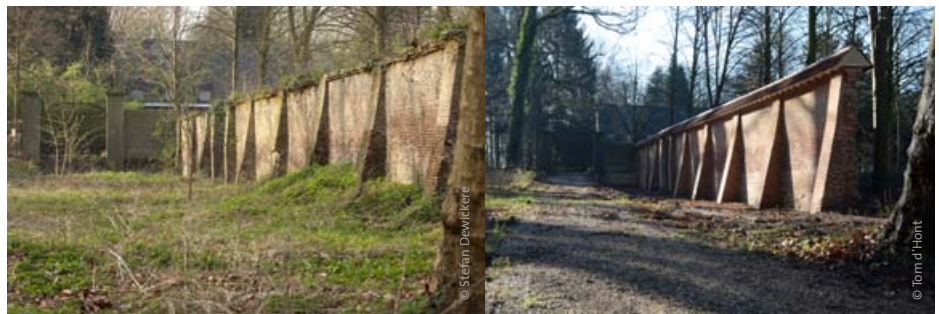
De tuinmuur voor en na restauratie
