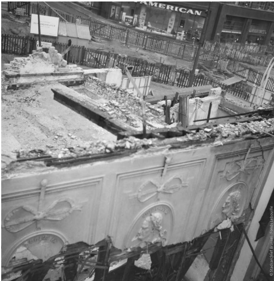
Tijdens de sloop maakt Marcel Lebouille bijna tweehonderd foto's, hij kruipt zelfs op het dak
