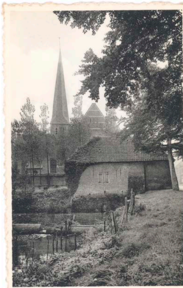
Op deze foto uit de jaren 1960 is onder het raam van de brouwerij nog een sasje te zien. Daar eindigde de goot en liep het Vlietwater in het reservoir. Een laag muurtje zorgde ervoor dat het vuil kon bezinken en er enkel zuiver water verder stroomde.
