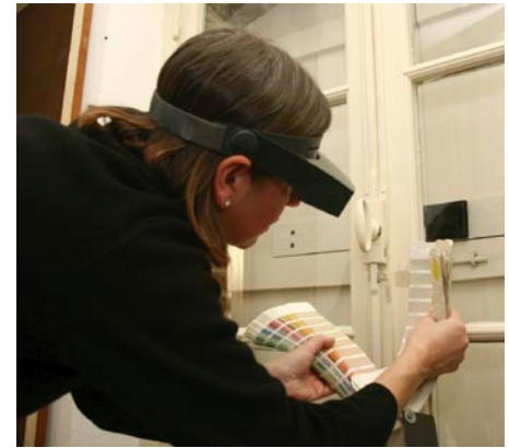
De gemaakte proefvensters worden vergeleken met de kleurenkaart om de juiste kleurenreferentie te vinden
